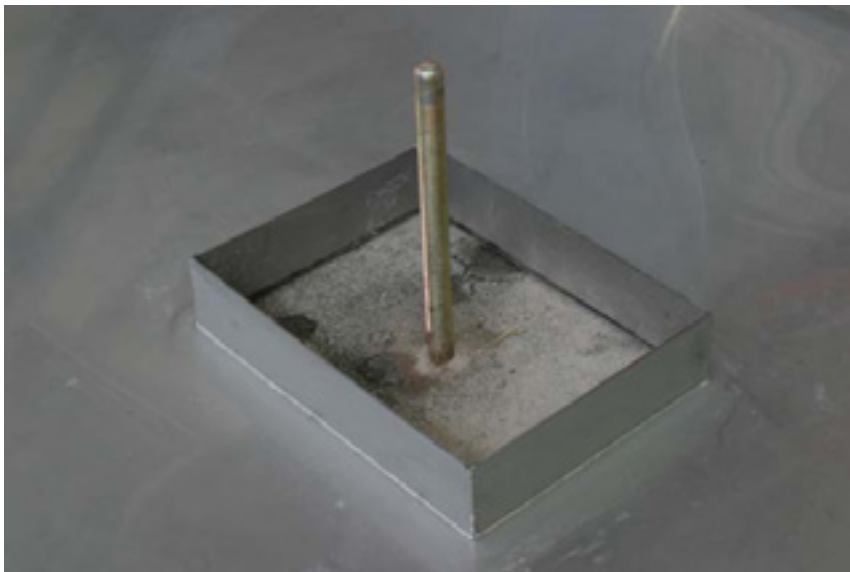
Wannendurchbruch für einen Maschinenfixator
